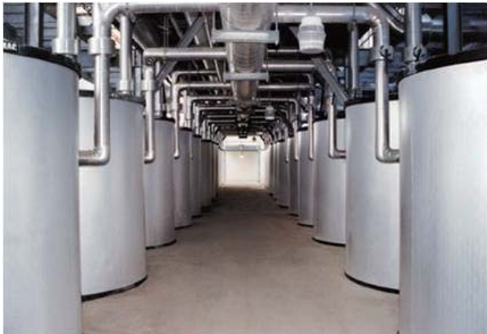
图1-5-1 冰桶现场布置
